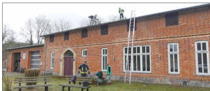
Dachreinigung am Dorfgemeinschaftshaus in Kladow
